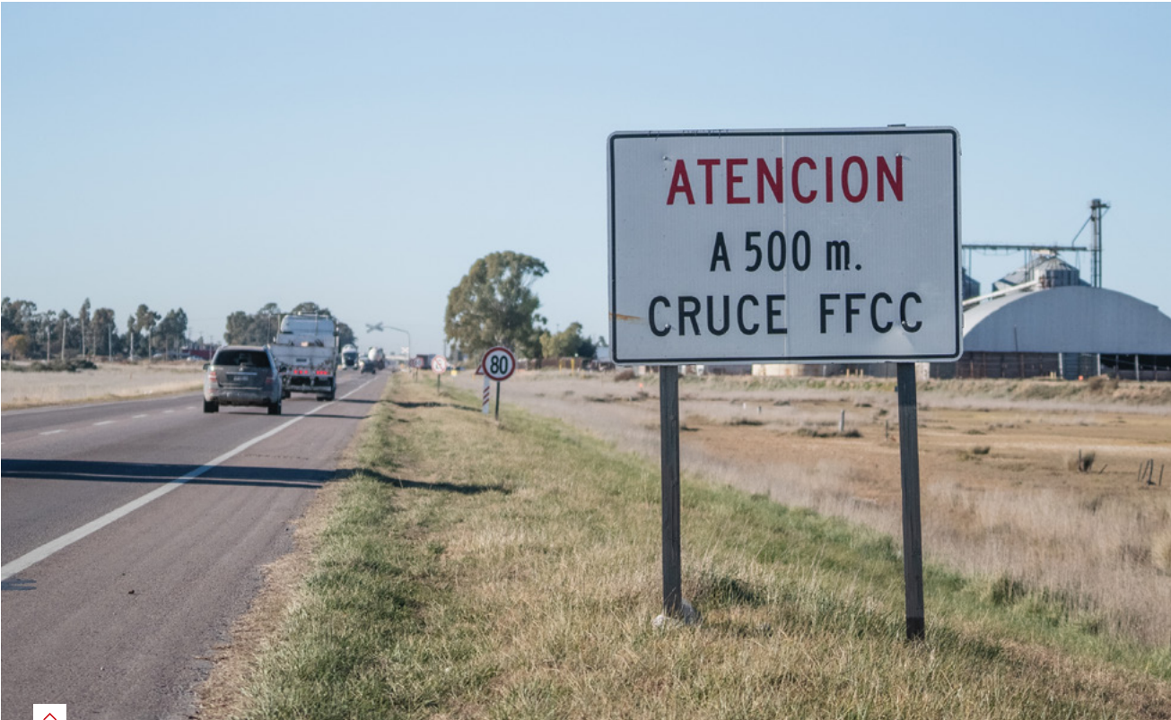
Señalización ferroviaria cercana a pasos a nivel.
